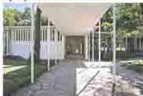
Sep Ruf – Architekt der Moderne
